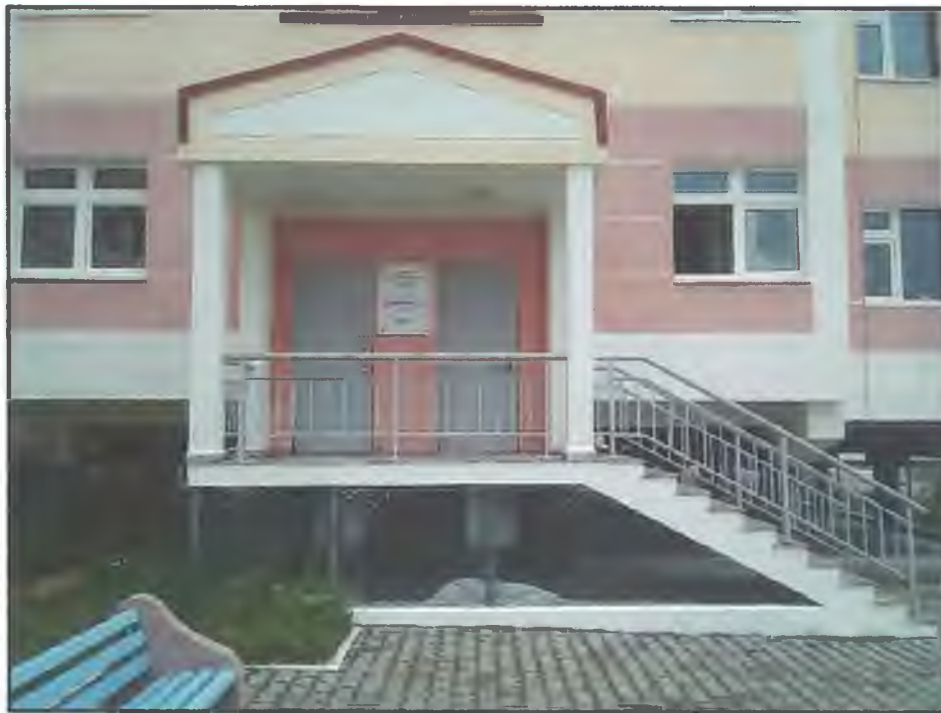
Фото В1. Вход в здание и наружная лестница
