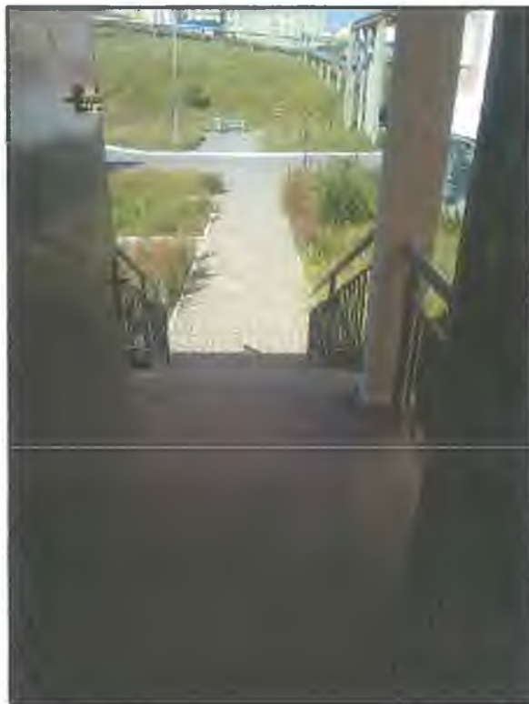
Фото П6. Выход эвакуационный
