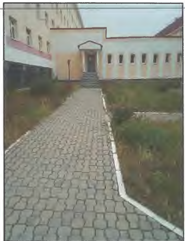
Фото В3. Выход эвакуационный
